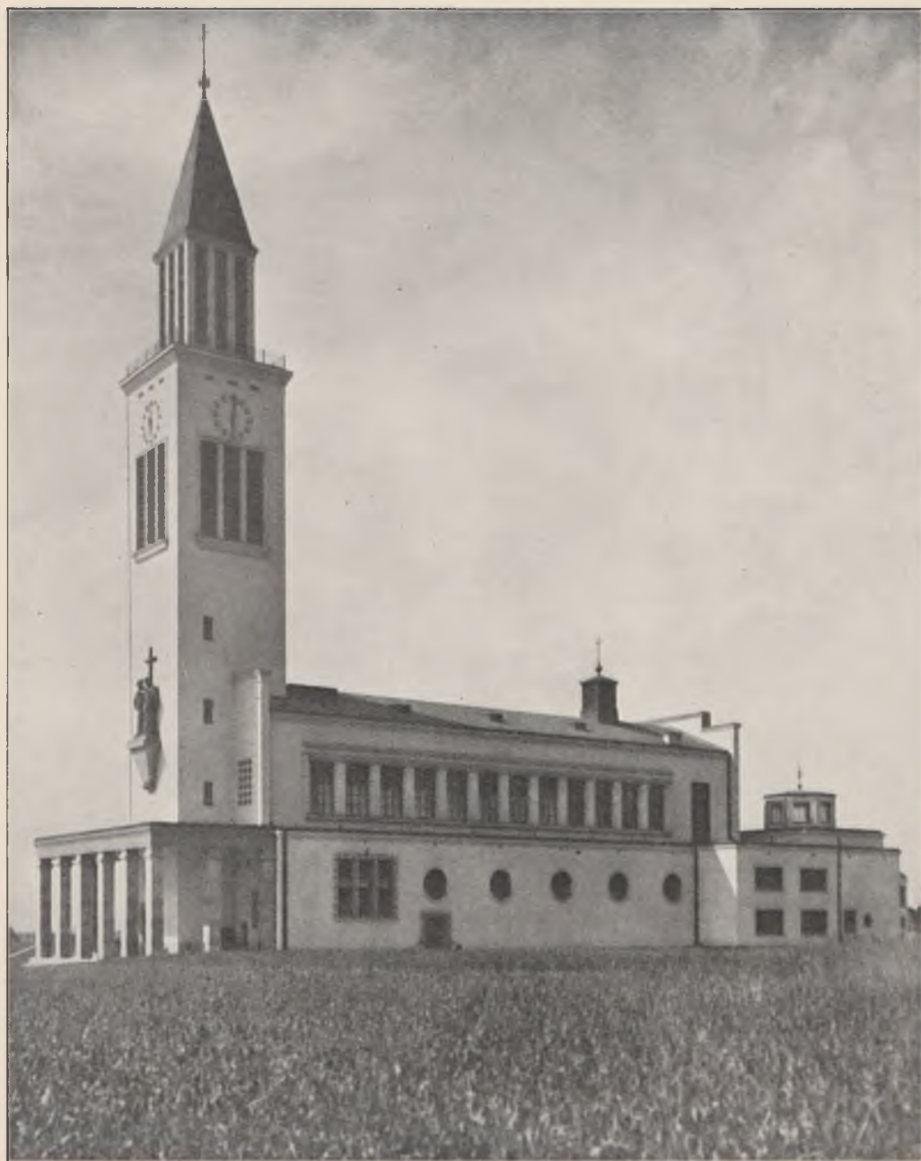
CELKOVÝ POHLED OD JIHOVÝCHODU
