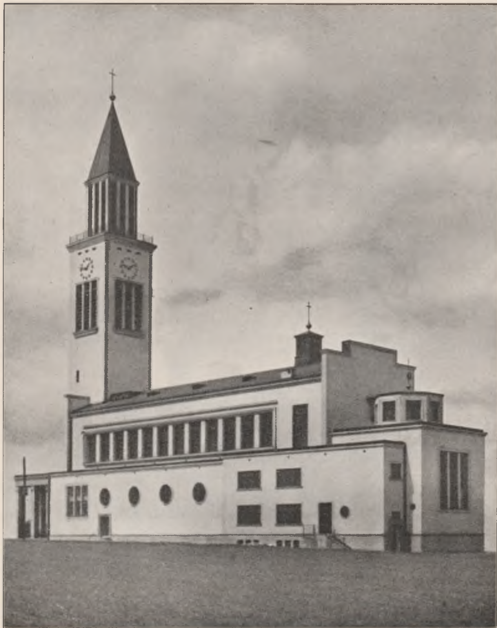
POHLED OD SEVEROVÝCHODU
