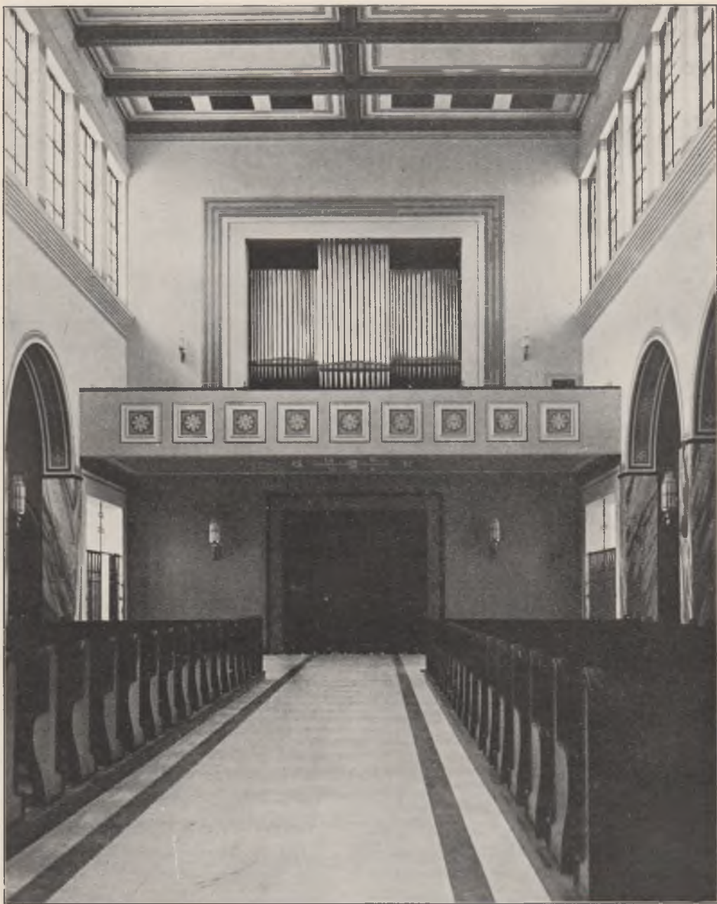
VNITŘEK – POHLED KE KŮRU
